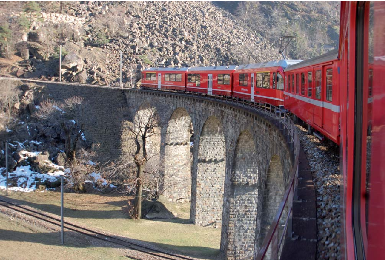
il treno dopo avere superato un dislivello di 70 metri all'uscita del viadotto di Brusio
