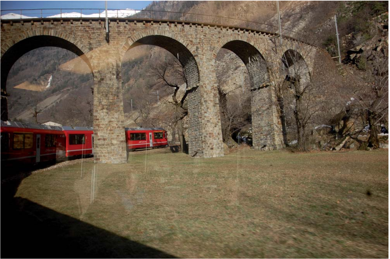
il treno sotto il viadotto elicoidale di Brusio
