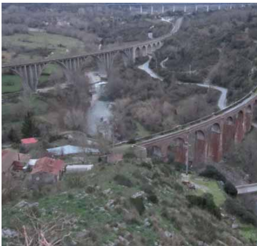
Ponte sul Mingardo
