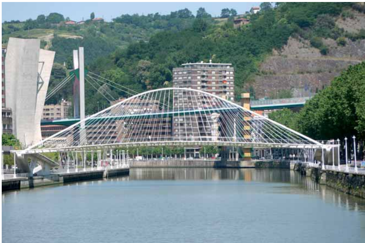
Bilbao, il modernissimo ponte pedonale Zubizuri progettato da Calatrava vicino al Museo Guggenheim
