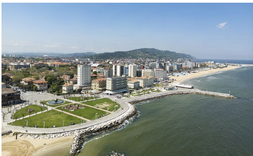
Veduta aerea del Piazzale della Libertà - Archivio fotografico della Regione Marche
